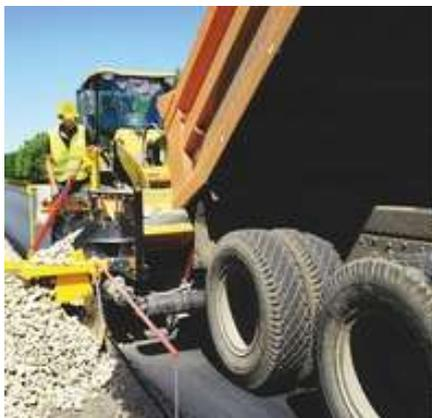
Отсыпщик обочин предназначен для распределения инертных материалов (щебень, песок, ПГС), а также холодных и горячих смесей с  $t^{\circ}$  до  $200^{\circ}\text{C}$ , при укреплении обочин, уширении оснований проезжей части.
